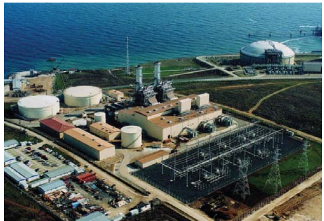
Marmara Ereğlisi Doğal Gaz Çevirim Santrali
